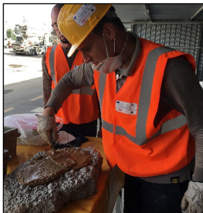
Prova di spandimento malta geopolimerica in sito
